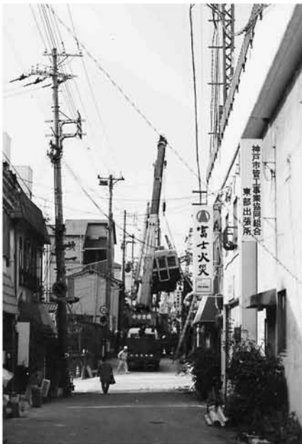
阪神電車撤去作業の現場
