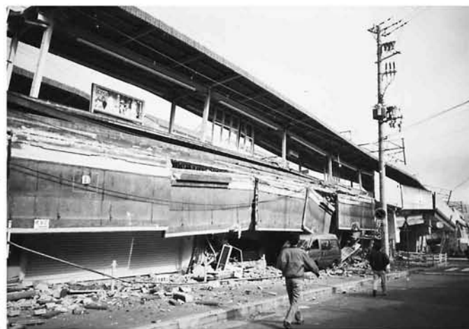
崩壊したJR六甲道駅
